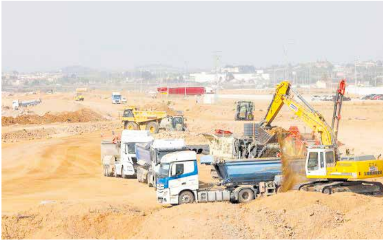
Construcción de la planta en Sagunt. / ANA ESCOBAR (EFE)
