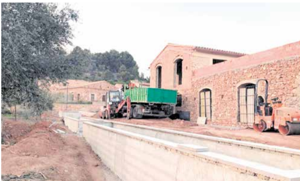
Momento de las obras junto a la vivienda afectada en Alfara de la Baronia. / EPDA
