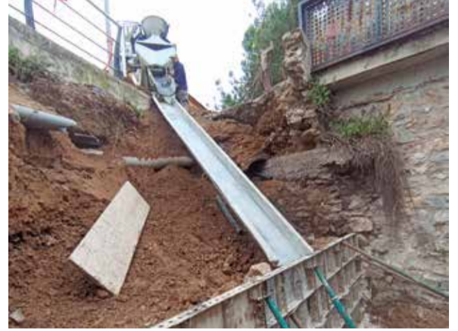
Labores de reparación en la Jarea. / EPDA
