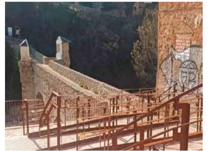
Rampa situada en Montanejos. / EPDA
