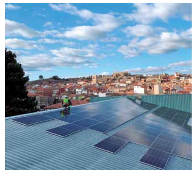
Instalación de las placas solares en un tejado / EPDA
