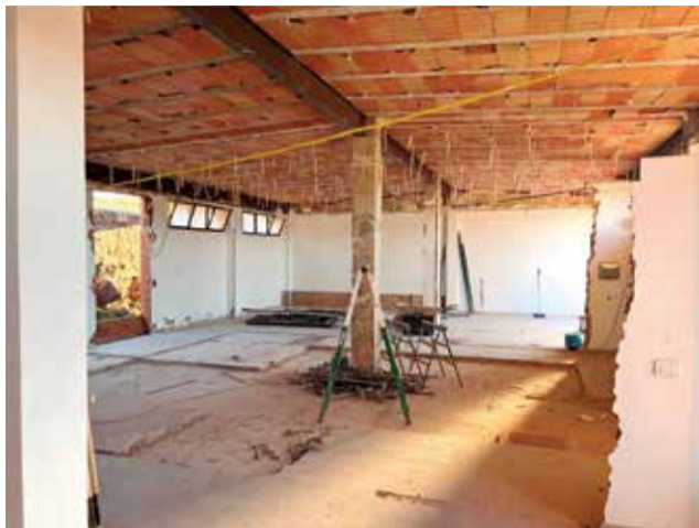
Obras llevadas a cabo en el polideportivo. / EPDA
