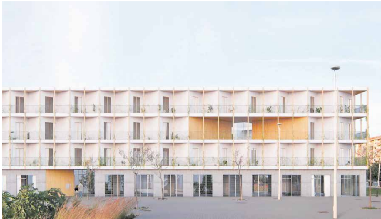
Vista de la façana del nou edifici de vivendes protegides a Gandia. / EPDA
