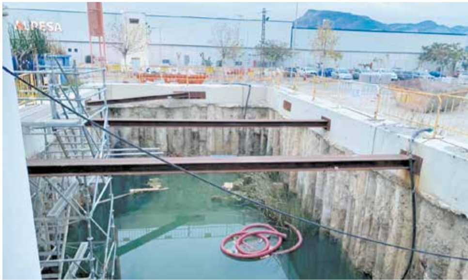
L'estat de les obres de l'estació ferroviària de Tavernes. / EPDA
