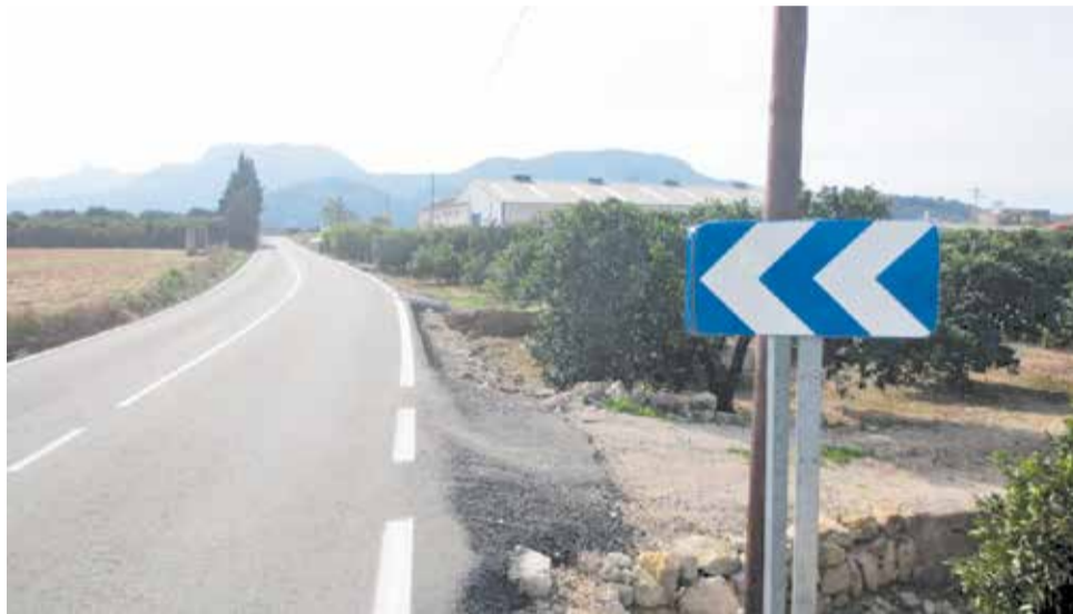
Visita d'autoritats i tècnics (sup.) i estat de la via abans de les obres (inf.) / EPDA
