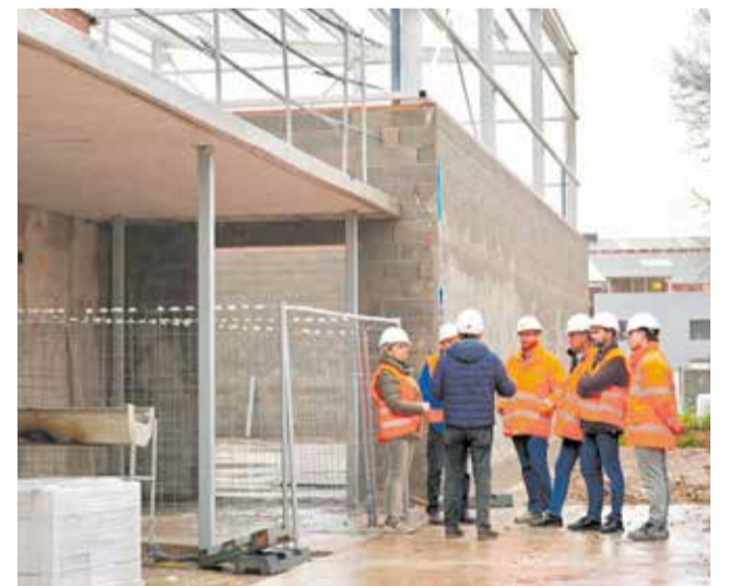
Visita a las obras del IES Ximén de Urrea. / EPDA
