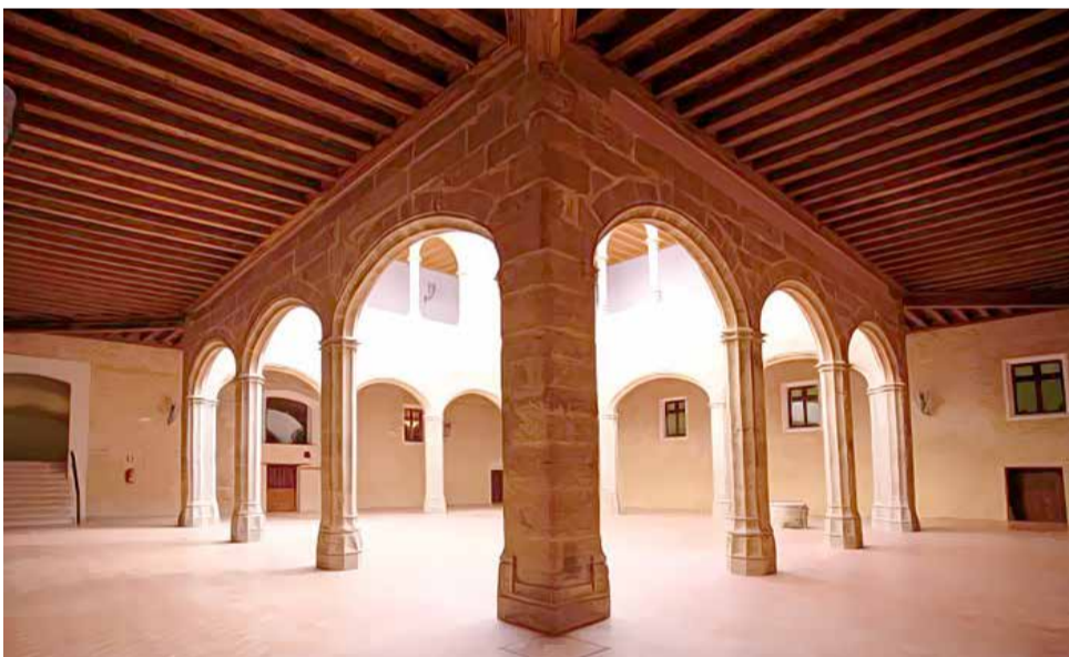
El Castell d'Alaquàs acaba de complir el centenari de la seua recuperació. / EPDA
