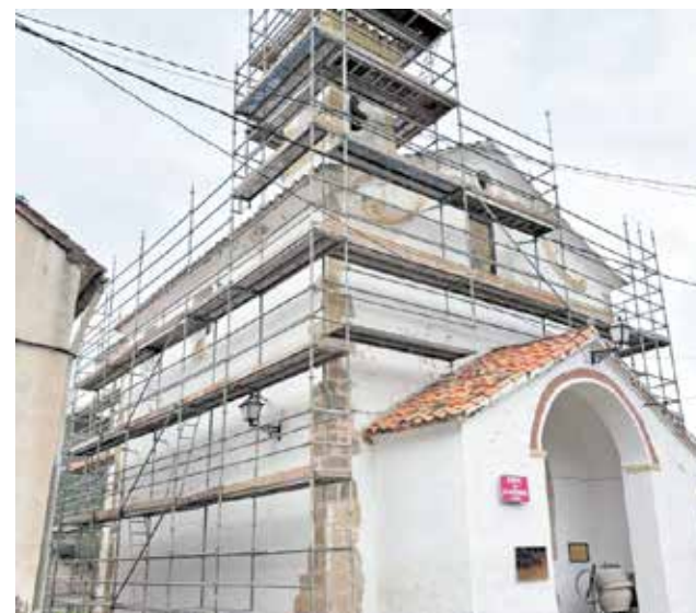
Inicio de la rehabilitación de la ermita. / EPDA
