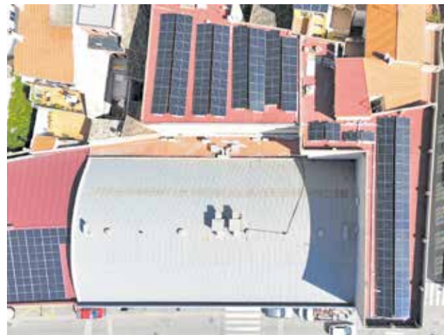
Paneles instalados en el Salón sociocultural. / EPDA
