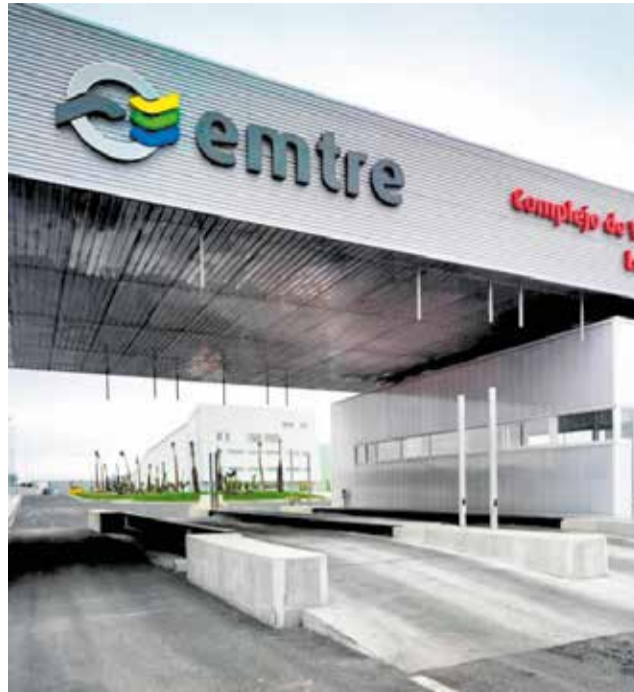
Les instal·lacions de l'EMTRE. / EPDA
