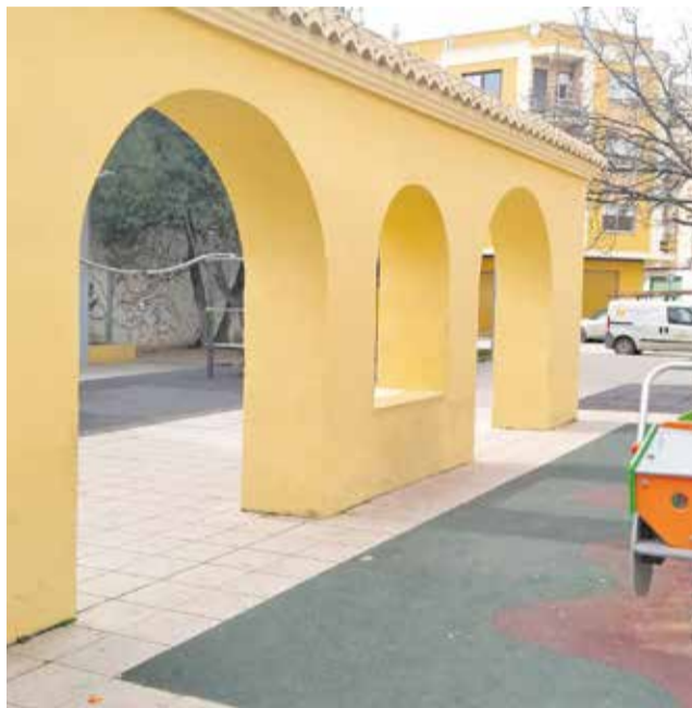
Diferentes obras realizadas por el consistorio requenense. / EPDA
