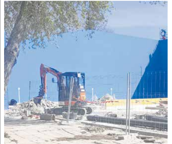
Detalles de la reconstrucción. / EPDA
