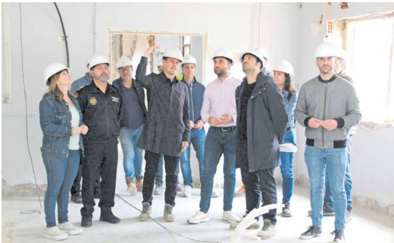
Un instant de la visita d'autoritats, tècnics, cos policial i representants de la constructora. / EPDA
