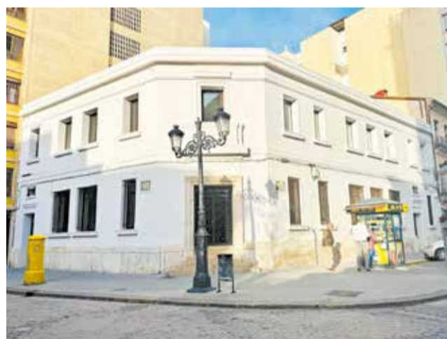
L'antic edifici de Correus de Sueca. / EPDA
