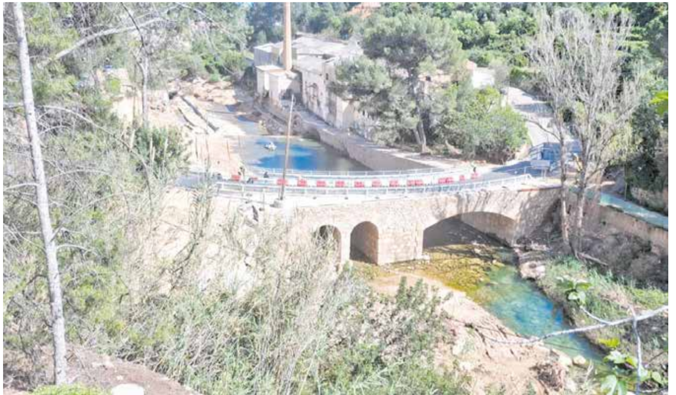
Abre al tráfico el puente de la Jarra en Buñol y continúa acondicionando el entorno en la CV-427. / EPDA
