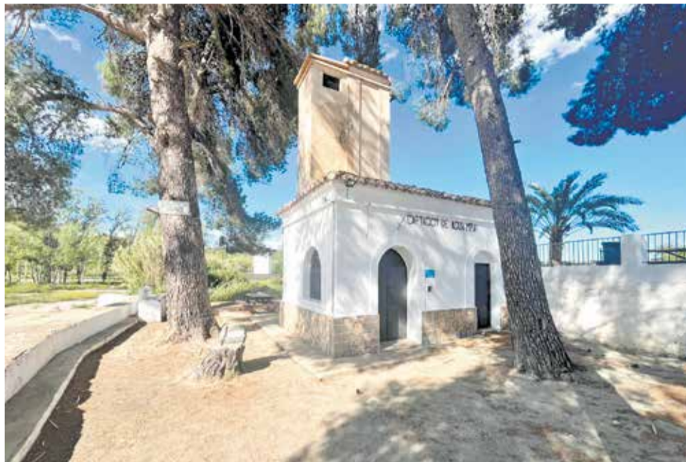
Captación de agua municipal de Soneja. / EPDA
