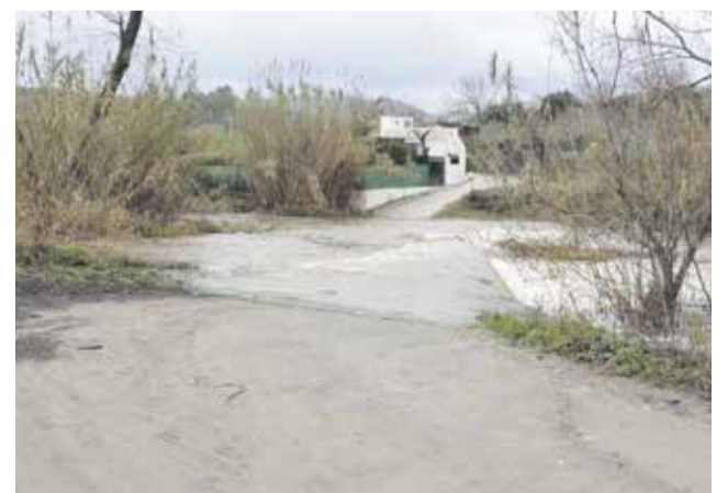
Camino afectado por las lluvias de octubre. / EPDA
