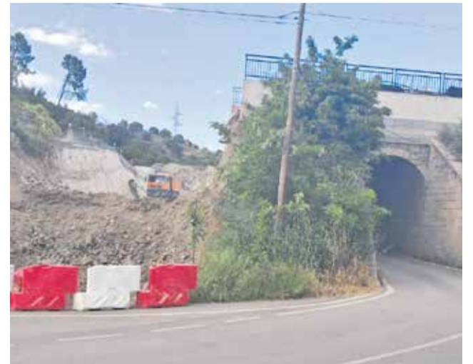
Tramo de la carretera en obras. / EPDA
