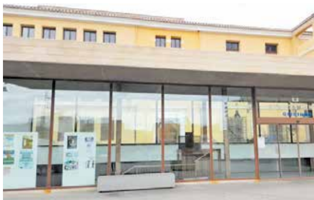
Vista exterior de las oficinas del consistorio. / EPDA
