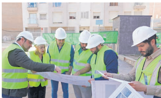
Natalia Enguix visita las obras. / EPDA
