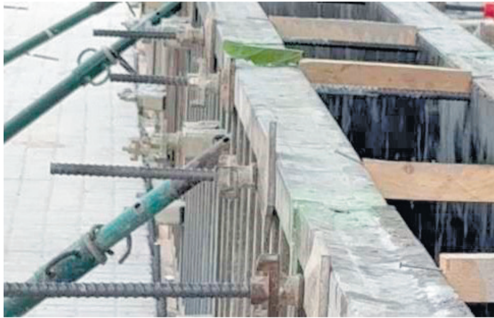
Uno de los muros de la infraestructura que están construyendo. / EPDA
