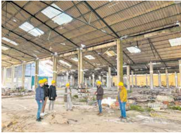
Visita de treball a l'antiga fàbrica Sanchis. / EPDA
