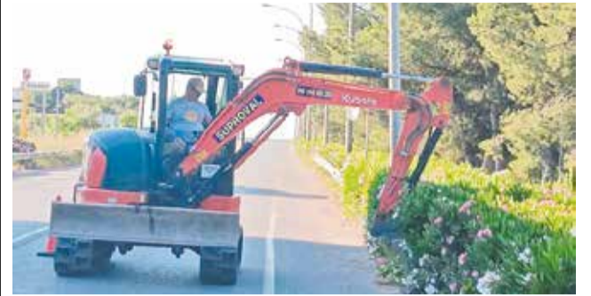
Inici dels treballs de la nova via. / EPDA
