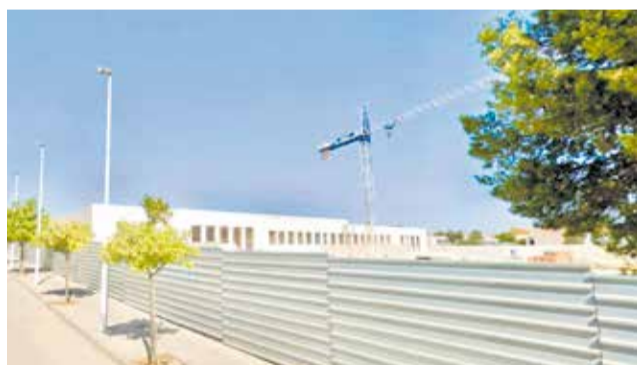
Estado de las obras de la Casa de la Cultura. / EPDA
