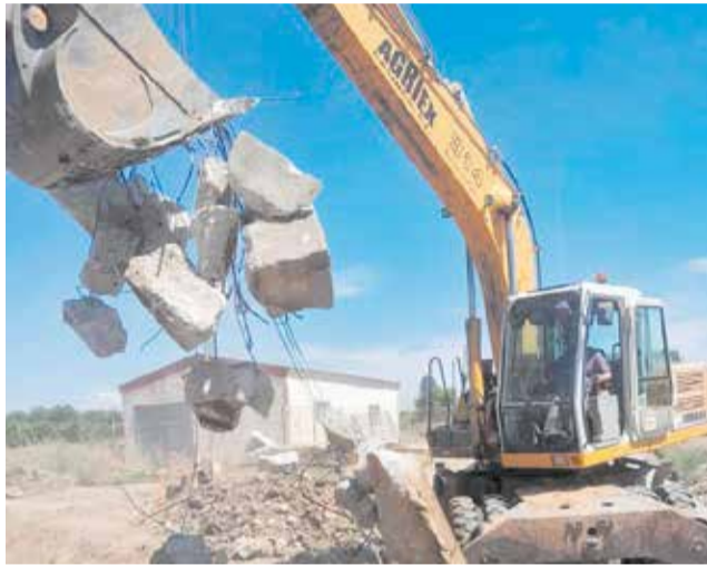
Demolició de l'antic pont de La Pineda. / EPDA
