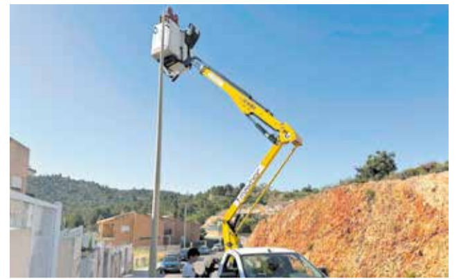
Cambio de luminarias en una urbanización. / EPDA
