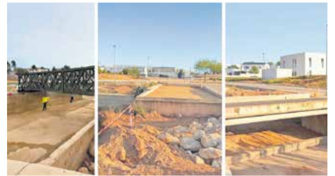
Trabajos en los puentes de Loriguilla. / EPDA
