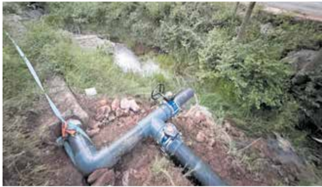
Trabajos de mejora en la conducción del agua. / EPDA
