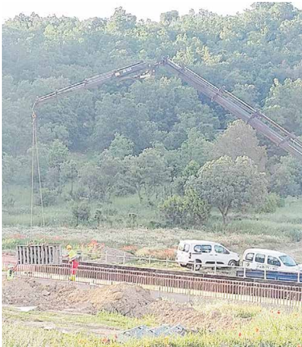
Treballs del Ministeri de Transports en la carretera N-232./ EPDA
