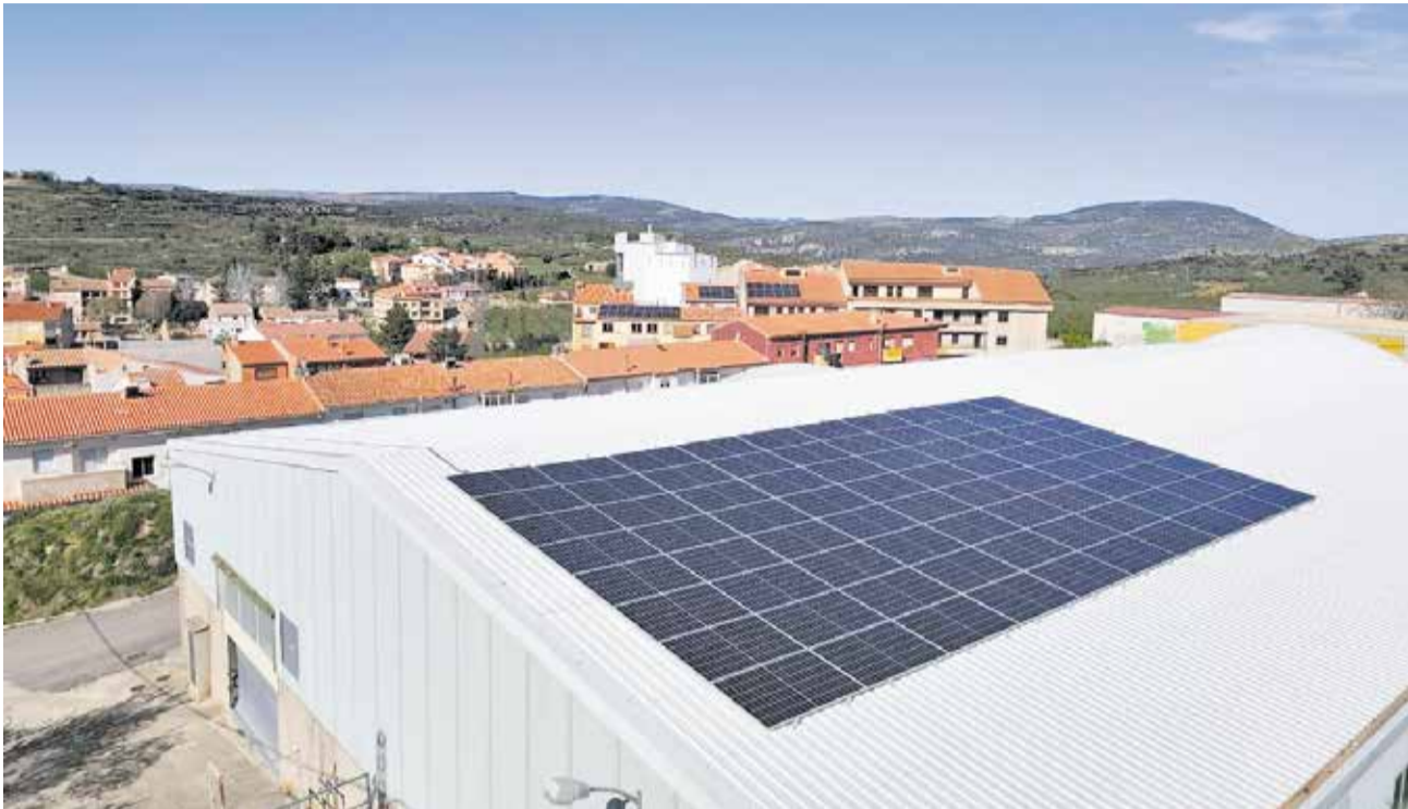
Instal·lació fotovoltaica a Benassal. / EPDA
