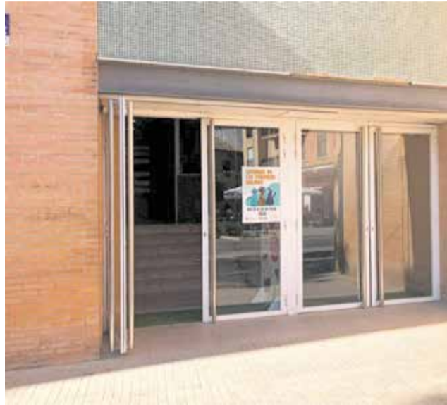
L'accés a l'edifici de la Casa de la Música. / EPDA
