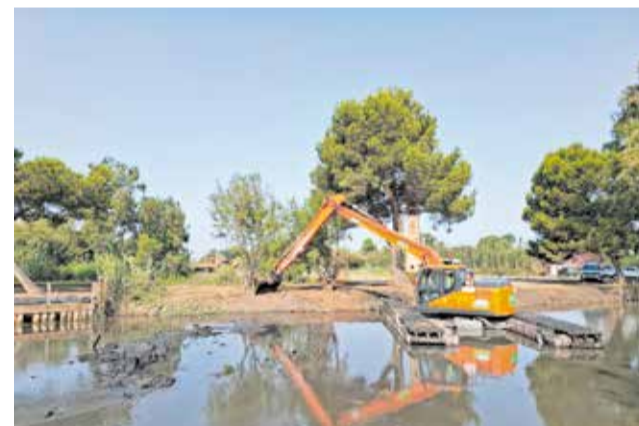
L'actuació de dragat del Port. / EPDA
