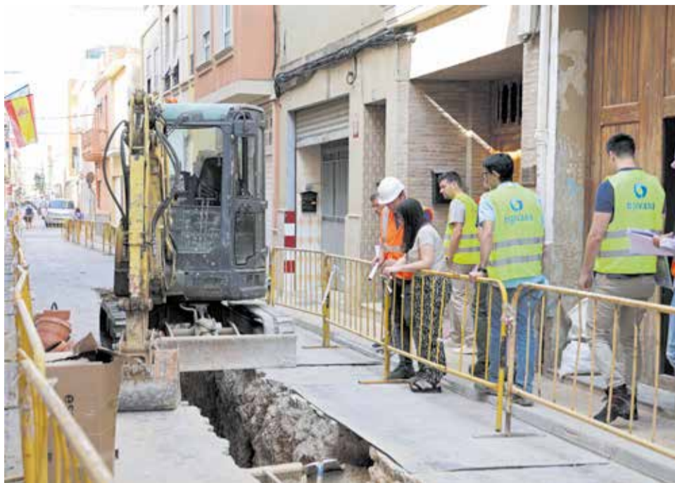
Els operaris treballen en el clavegueram d'un carrer. / EPDA
