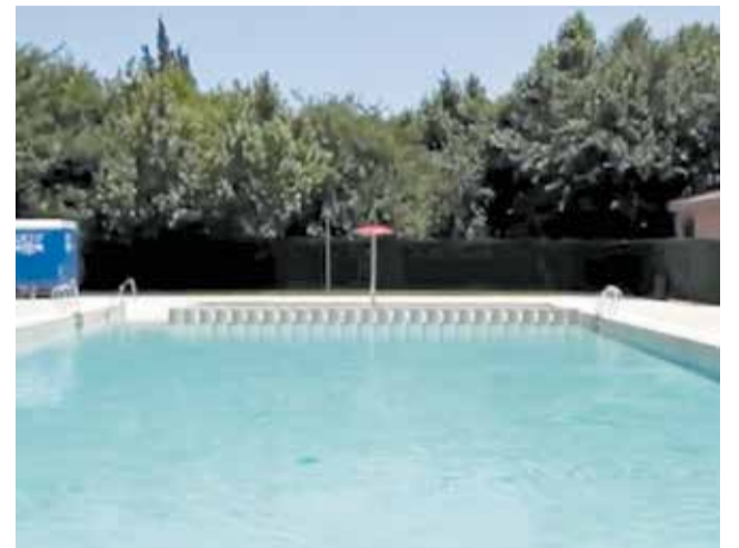
Piscina de Bugarra tras su recuperación. / EPDA
