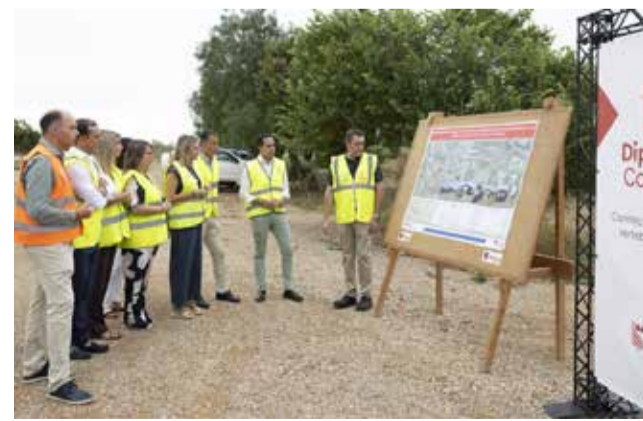
Visita a les obres de la CV-138 a Càlig. / EPDA
