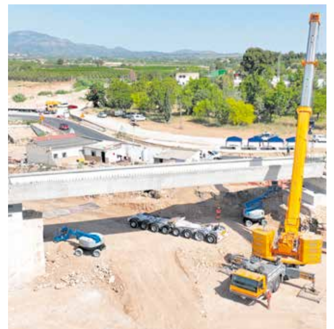
Obras de la CV-50 que une la comarca / EPDA
