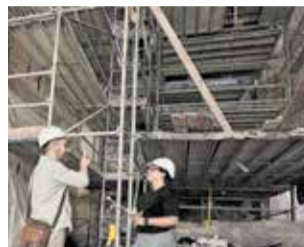
Visita a les obres. / N. FRANCÉS
