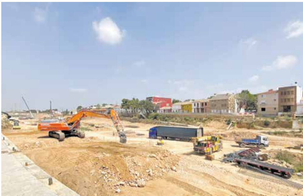
Les obres al barranc en Picanya. / EPDA
