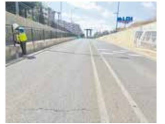
Obres al túnel. / EPDA
