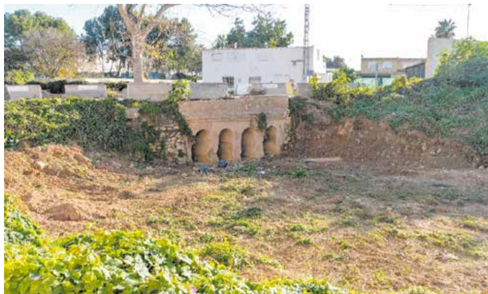
El puente sobre el barranco del Salt de l'Aigua. / EPDA
