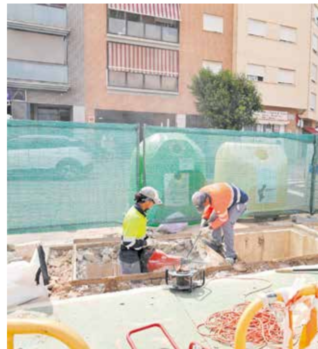
Els treballs per substituir les illes soterrades. / EPDA
