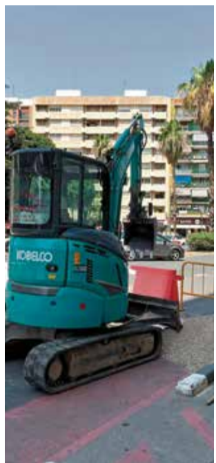
Maquinaria de obra./EPDA
