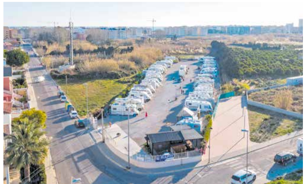
Vista aérea de la zona ubicada en Daimús. / EPDA
