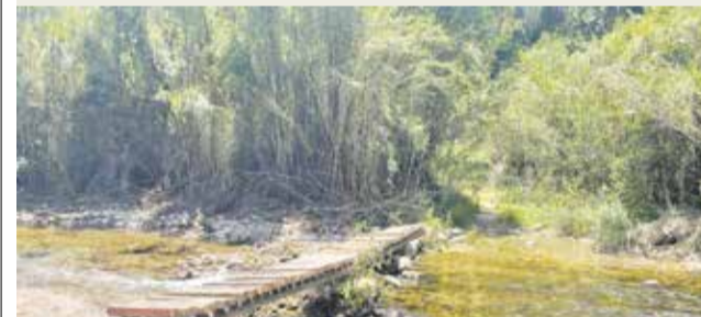
► El Ayuntamiento de Argelita ha instalado pasarelas en La Alameda, Martes, Molino y Santa Cruz para mejorar el senderismo, facilitar el acceso a rutas naturales y a las huertas. Además, fomenta las actividades saludables y la economía local.
