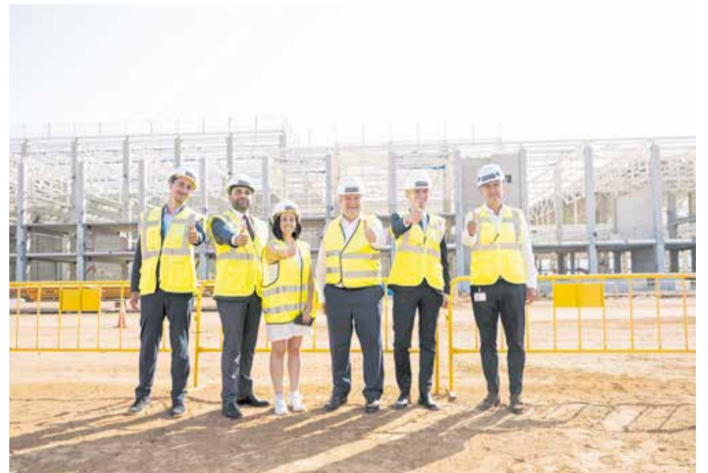
Les autoritats visiten les obres de la gigafactòria de PowerCo. / EPDA
