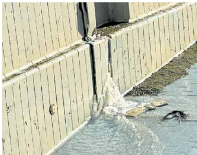
Problema en la piscina de Benifairó. / EPDA
