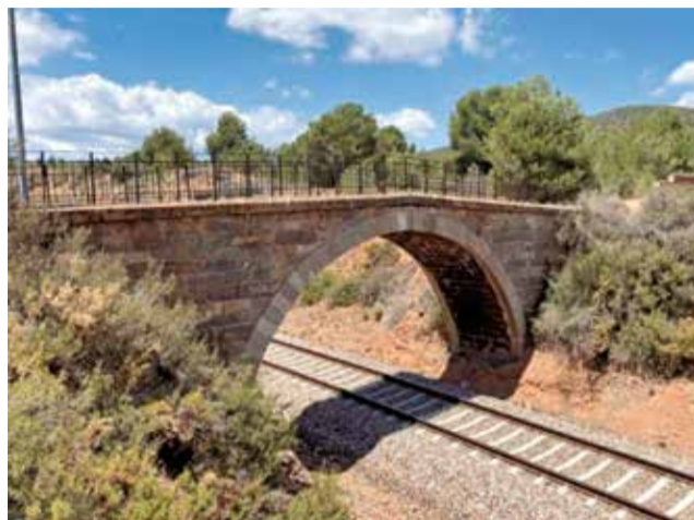
Puente ferroviario de la línea C5. / EPDA
