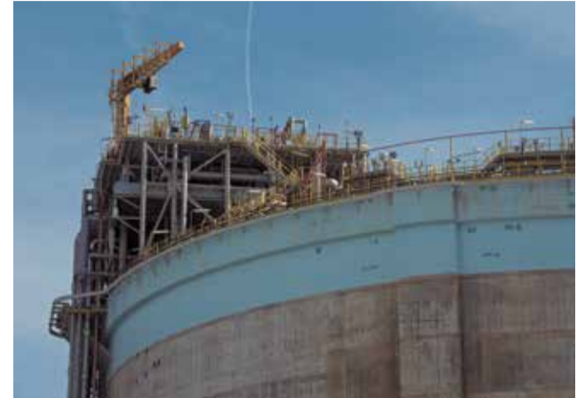
La planta de Saggas. / EPDA
