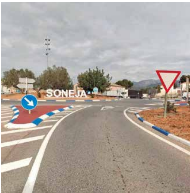
Acceso al polígono del Monte del Hoyo / EPDA
