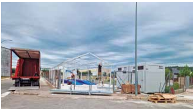
Trabajos de instalación de la ITV en Segorbe. / EPDA
