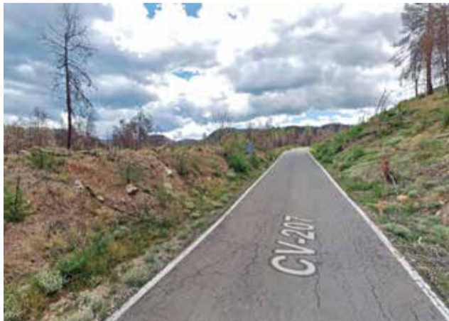
Tramo de la CV-207 antes de los arreglos. / GOOGLE MAPS
