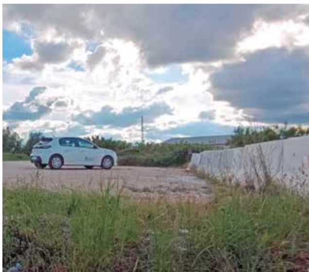
Blocs de formigó entre la CV-129 i la CV-164. / EPDA
