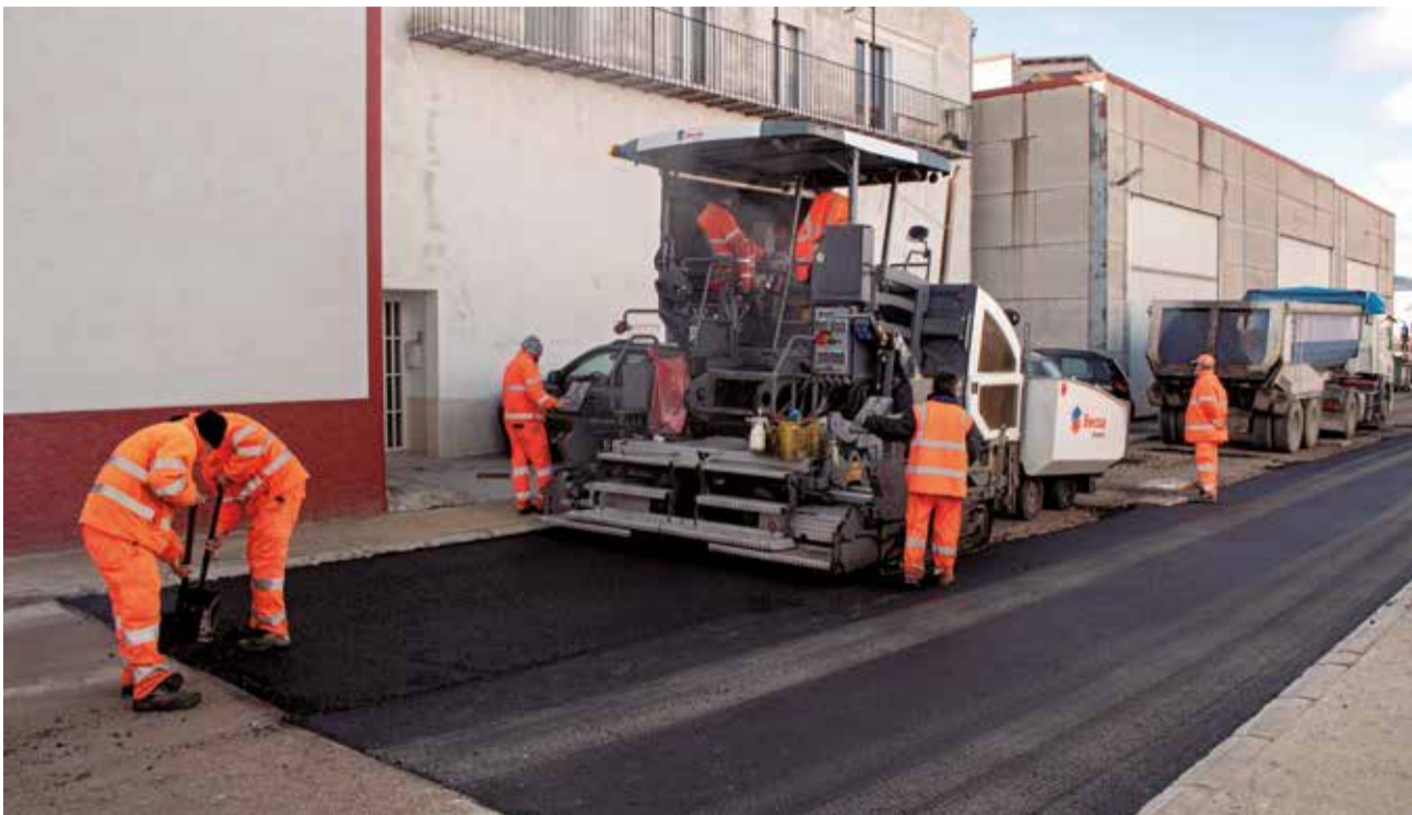
Treballs d'asfaltatge al polígon industrial Les Casetes de Morella. / EPDA
