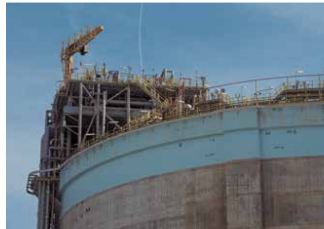
La planta de Saggas. / EPDA
