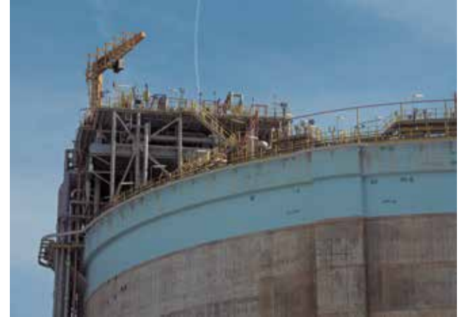
La planta de Saggas. / EPDA
