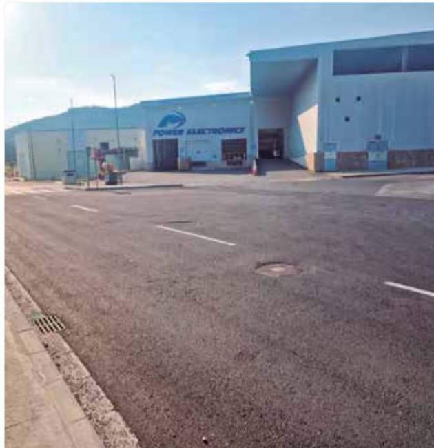
Mejoras en el polígono industrial. / EPDA
