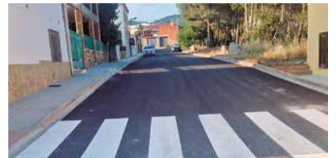
Trabajos en diferentes calles del casco urbano. / EPDA
