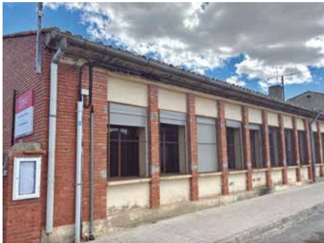
Comedor escolar de Camporrobles. / EPDA
