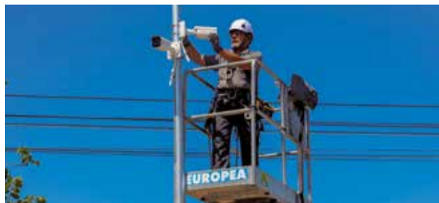
Un operari instal·lant les noves càmeres. / EPDA
