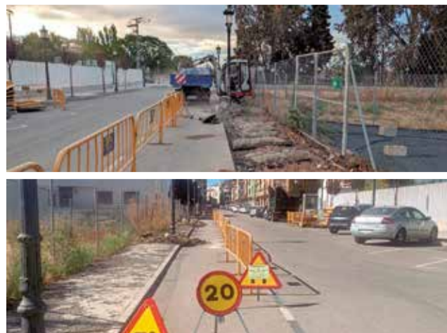
Trabajos en la calle Alejandro García de Utiel. / EPDA
