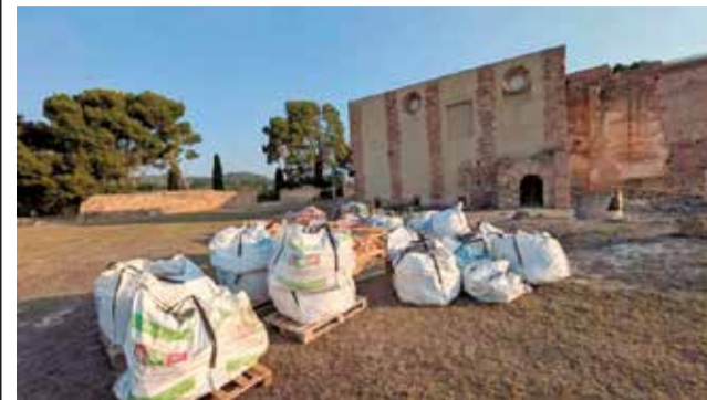
Inicio de los trabajos en la Cartuja de Valldecríst. / EPDA
