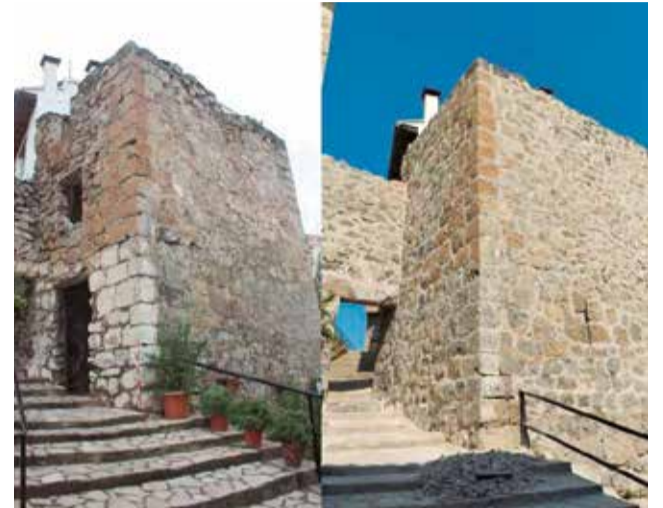
Comparación del antes y el después de las obras. / EPDA
