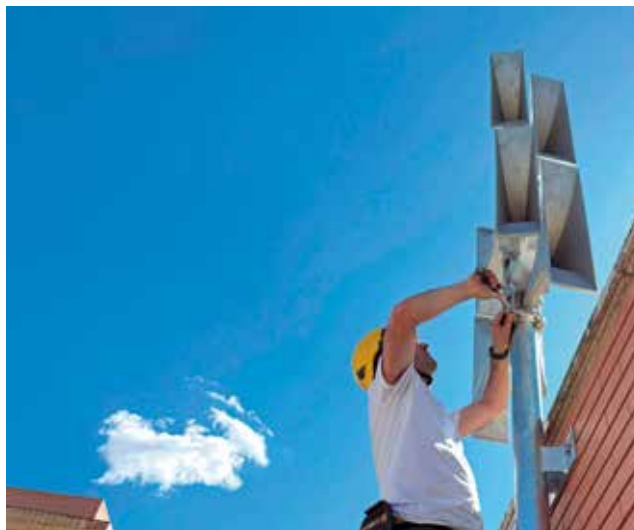
Instal·lació de l'alarma. / EPDA
