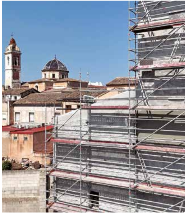
Obres del Convent dels Àngels d'Alberic. / EPDA
