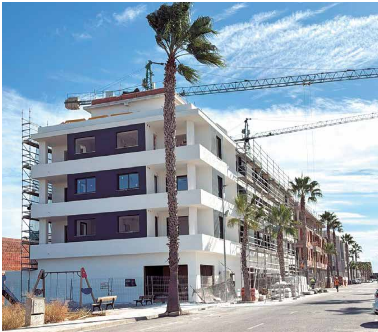
Una finca en construcción en un municipio de l'Horta Nord. / EPDA
