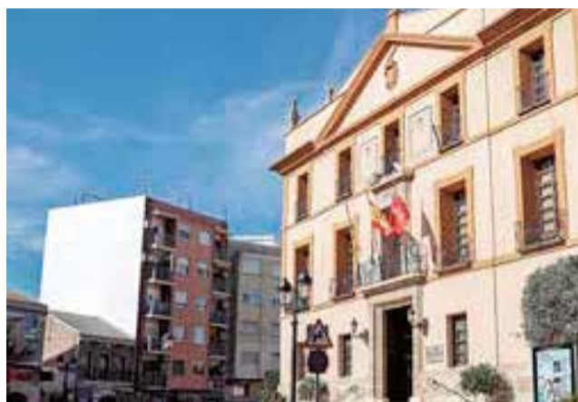
La fachada del ayuntamiento. / EPDA
