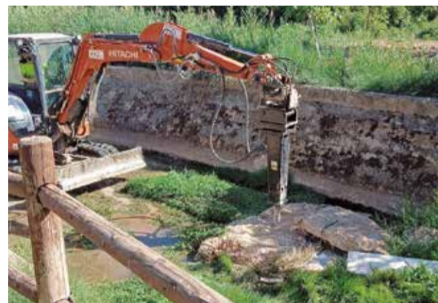
Trabajos de recuperación tras la dana. / EPDA
