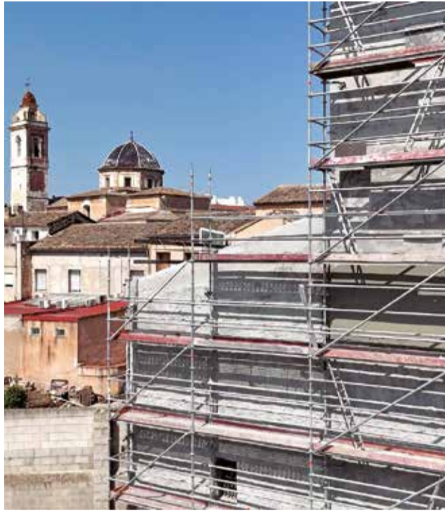
Obres del Convent dels Àngels d'Alberic. / EPDA
