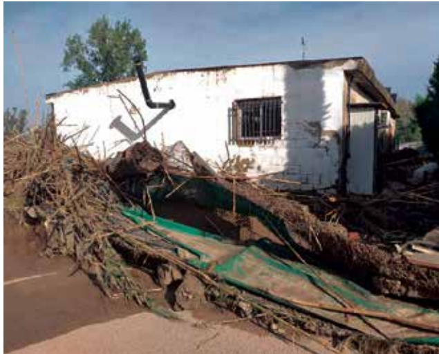
Una casa a una zona inundable de Riba-roja. / EPDA
