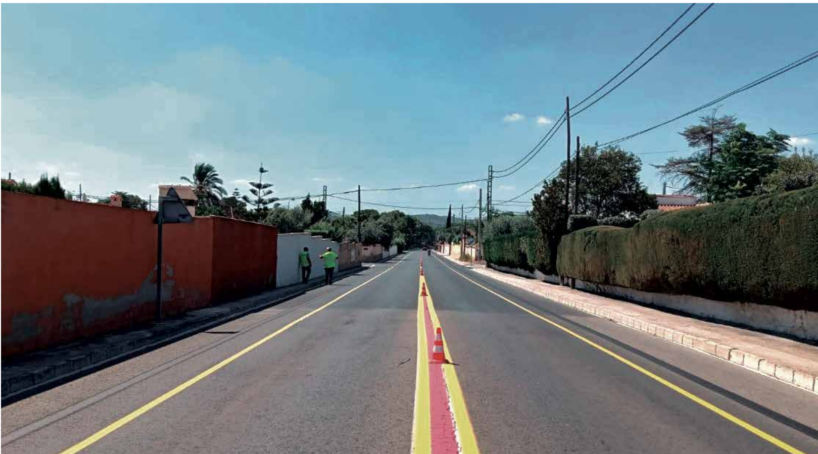
Obras en la travesía de l'Eliana en la carretera CV-336. / EPDA
