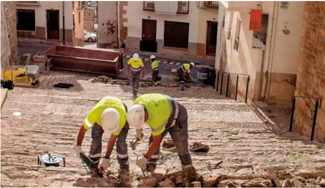
Treballs de reparació de les costes de Morella realitzats a través del taller d'ocupació. / EPDA
