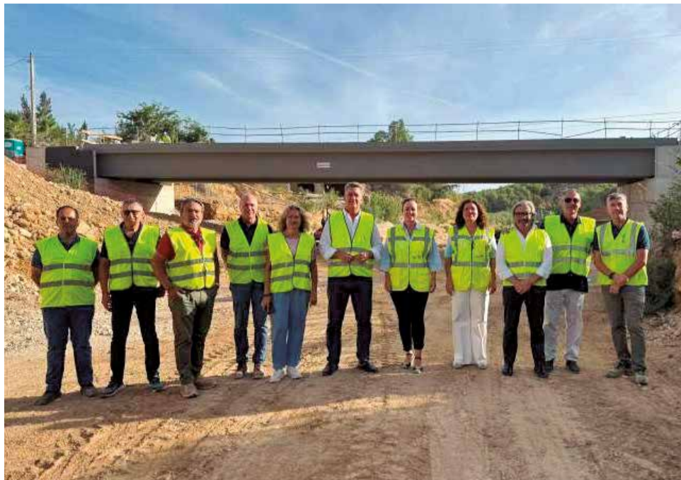
Martínez Mus visita la carretera afectada por la riada. / EPDA
