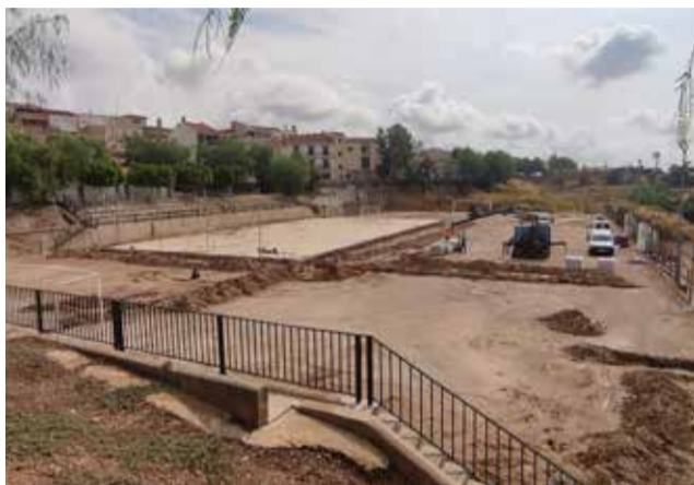
Inicio de las obras en el polideportivo de Losa. / EPDA
