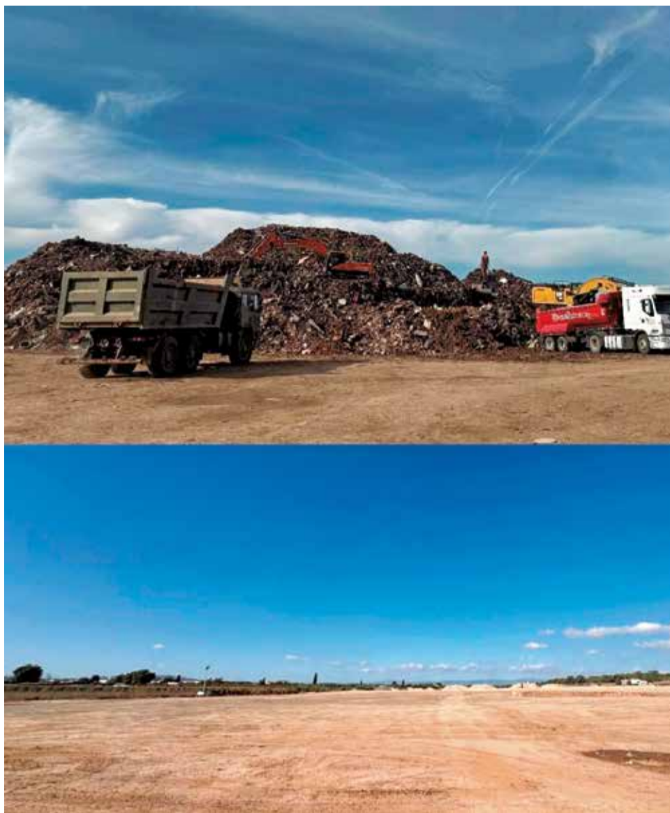
El antes y el después de la retirada de residuos. / EPDA
