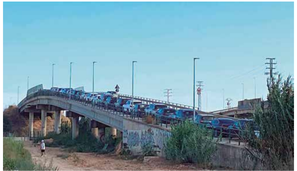
Los coches puestos a salvo en un puente de Massanassa. / EPDA
