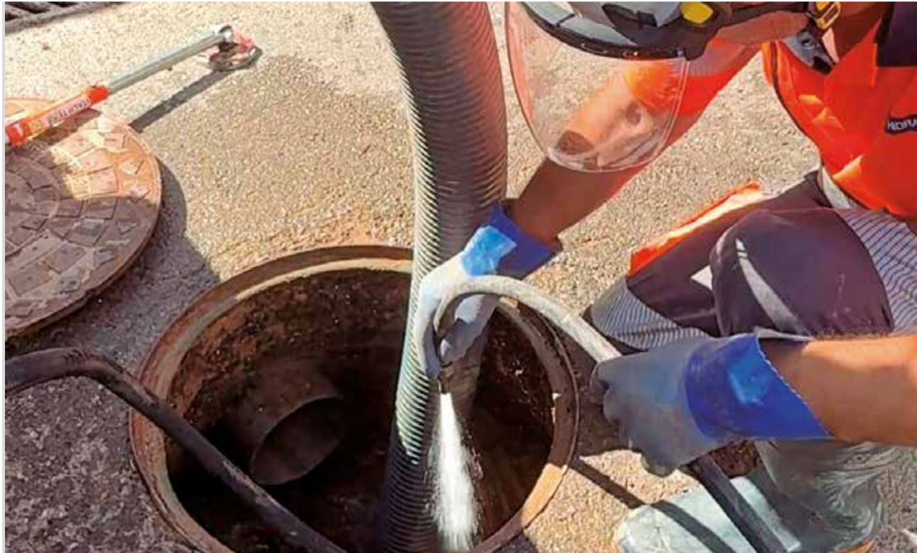
Los trabajos de revisión y limpieza de una alcantarilla. / EPDA
