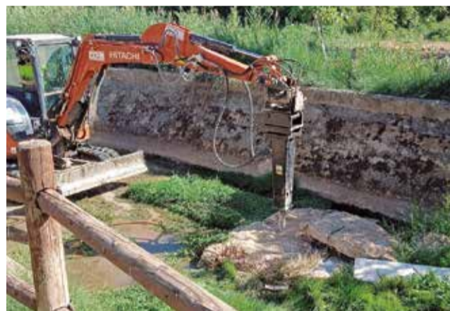
Trabajos de recuperación tras la dana. / EPDA
