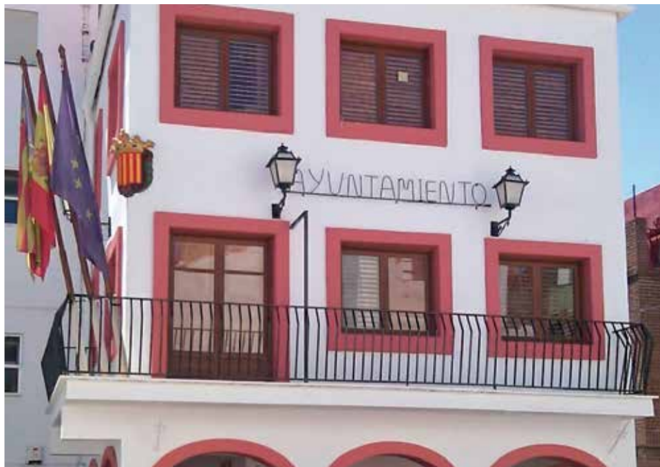
Fachada del edificio consistorial de Gátova. / EPDA
