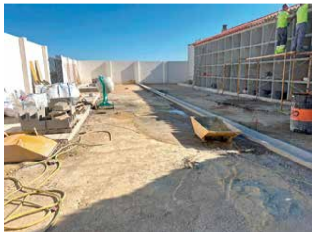
Obras en el cementerio de Marines. / EPDA
