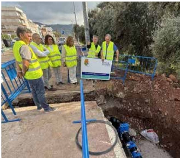
Obras de conexión de la desaladora y el centro. / EPDA
