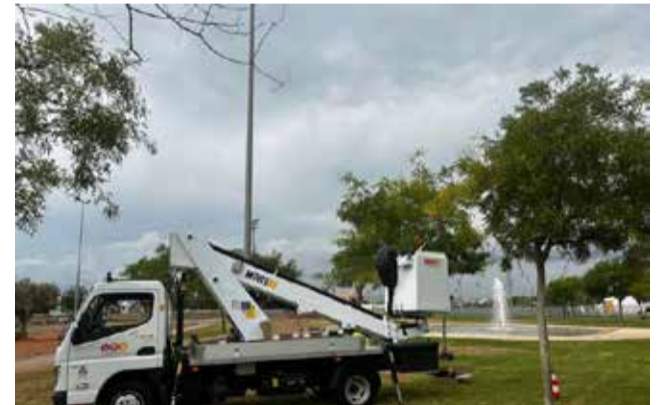
Trabajos de reparación eléctrica en el CEM. / EPDA
