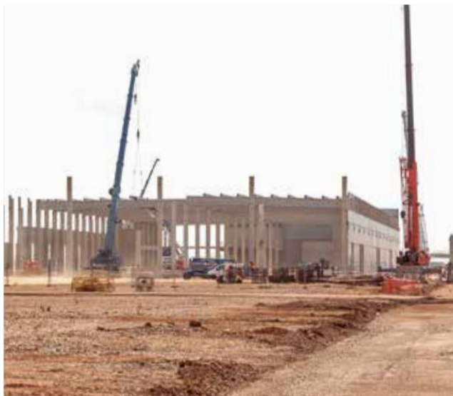
Obres de la gigafactoria de PowerCo. / FOTO: POWERCO
