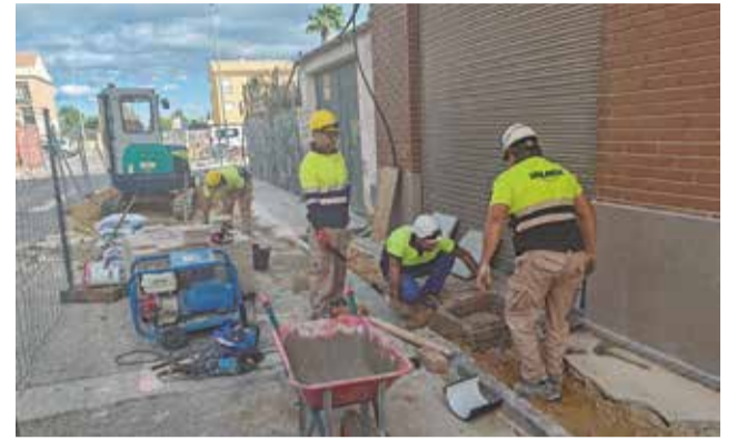
Diversos operaris en les obres. / EPDA
