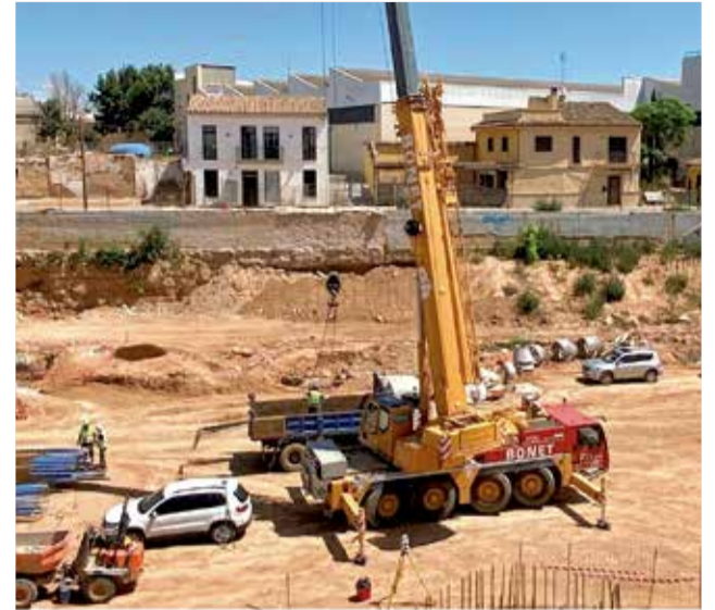
Les obres en el barranc a Picanya. / EPDA
