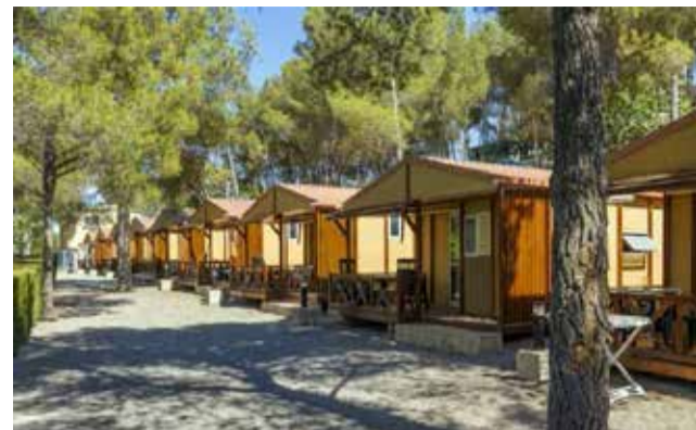
Instalaciones del camping de Segorbe. / EPDA
