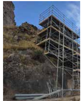
Castillo en obras. / EPDA
