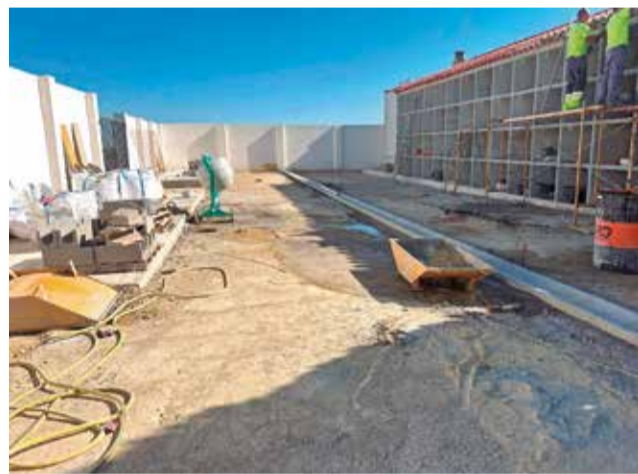
Obras en el cementerio de Marines. / EPDA
