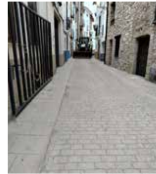
Obras en la calle Arriba/ EPDA
