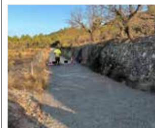
Trabajos de mejora. / EPDA
