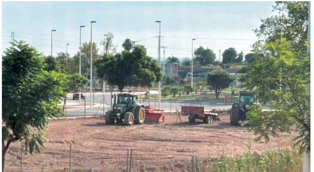
Diverses màquines treballen sobre el terreny previst per al tanatori. / EPDA
