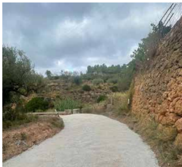
Tramo del Camino de Aragón mejorado/ EPDA
