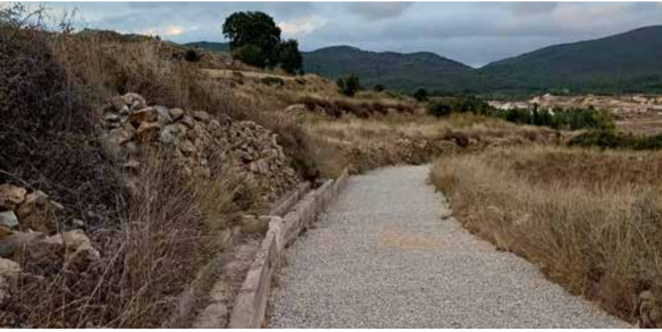
El sendero de los Arrieros tras los trabajos de mejora del recorrido. / EPDA
