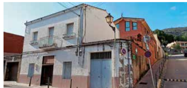
Casa on es construiran les vivendes. / EPDA
