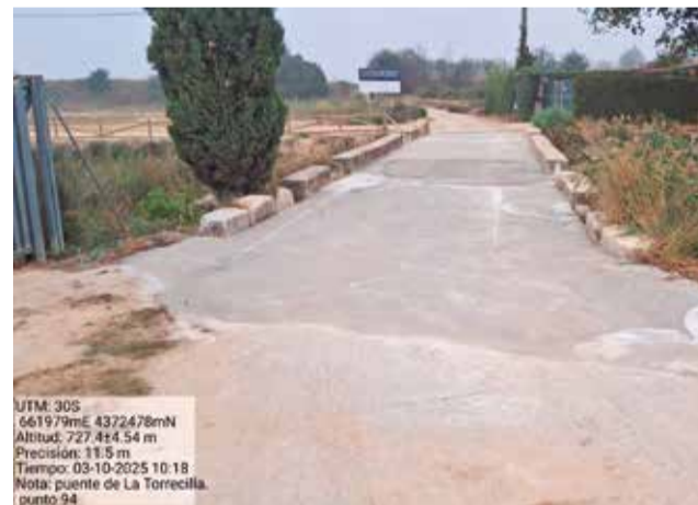
El camino de la Torrecilla reabierto al tráfico. / EPDA
