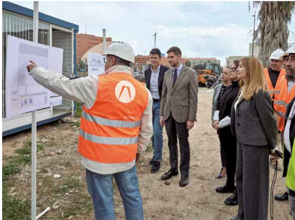
Un moment durant la visita a les obres. / EPDA
